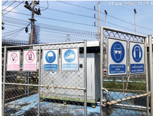
รูปที่ 61 ป้ายสัญลักษณ์เตือนอันตรายจุดเชื่อมต่อและส่งจ่ายก๊าซ NG
