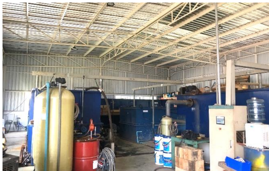
รูปที่ 20 ระบบบำบัดน้ำเสียแบบเคมี
